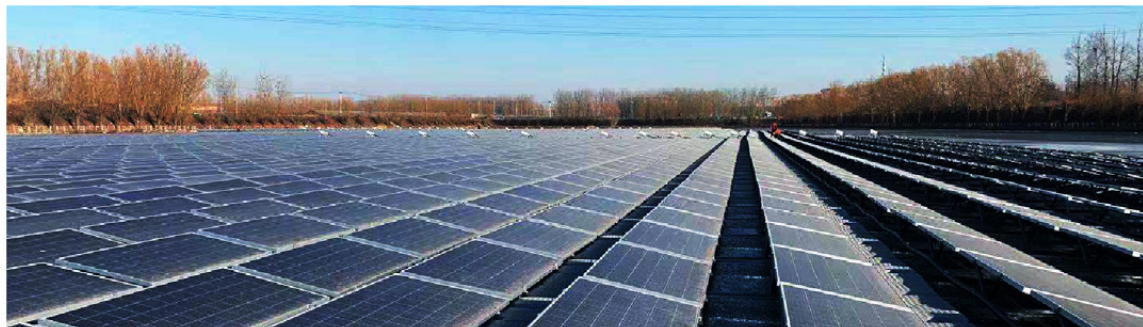
北京顺义（沉淀池）
