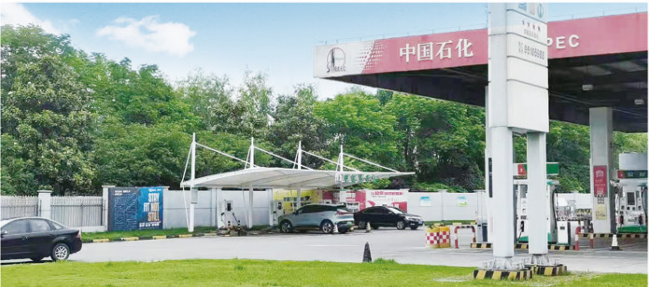
📍 苏州中石化项目
